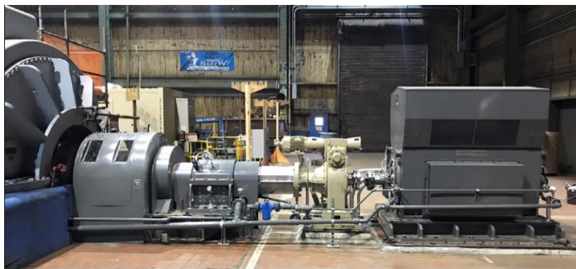
Figura 10: Reconversión de un generador a condensador síncrono de 140 MVA en Estados Unidos. Fuente: (EME, 2017).
