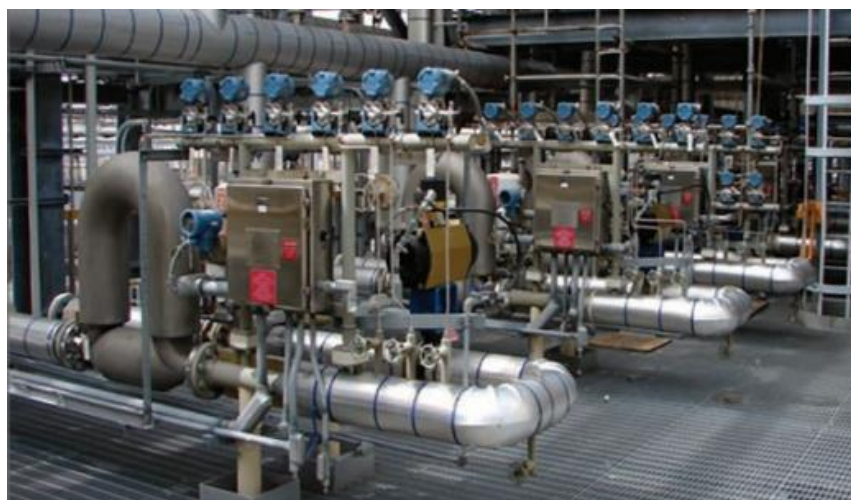
Figura 28: Sistema de mezclado de H_2 /GN (5%/95%) en la central de Dow Plaquemine, EE.UU. Fuente: (General Electric, 2021).
